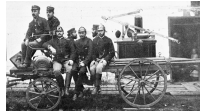
Erster Feuerwehrwagen mit Handdruckspritze Modell „Gugg“ der FF Eberschwang, Aufnahme 1894
